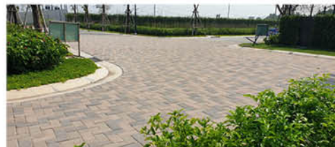
Khu đô thị Waterpoint (Long An) của Tập đoàn Nam Long. Waterpoint urban area Long An of Nam Long Group.
